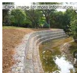
Fotografije: primeri ozelenjenih in z betonom kombiniranih stopničenih brežin z gabioni in betonskih dostopnih stopnic
